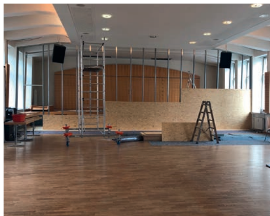
Juni: Einbau der Staubschutzwand im großen Saal
