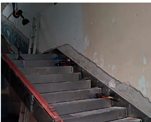
Oktober: Einbau der Stahltreppe im Fluchttreppenhaus
