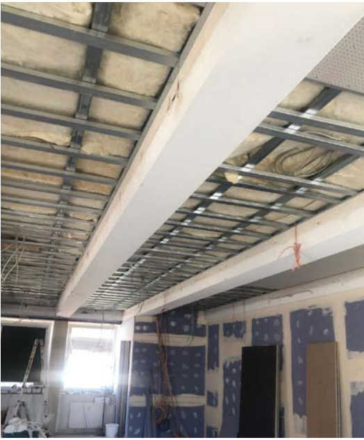
August: Neue Unterkonstruktion im kleinen Saal
